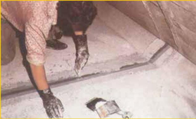
Vand Hypalon Tape ، سیستم درزگیری و آببندی درزها، با کارایی فوق العاده، مخصوص درزهای نامناسب با حرکات شدید که درون آنها واتراستاپ گذاشته نشده یا واتراستاپ موجود پس از بتن ریزی کارایی خود را از دست داده است.
